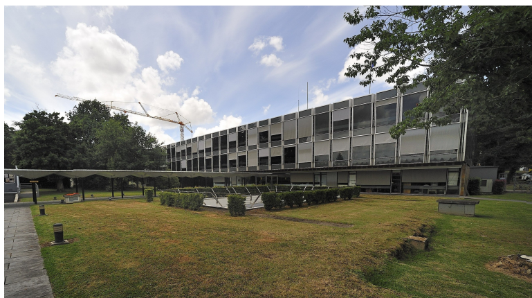
Bâtiment scientifique du site de Nantes de l'Iframer, hébergeant en partie le service VIGIES.
