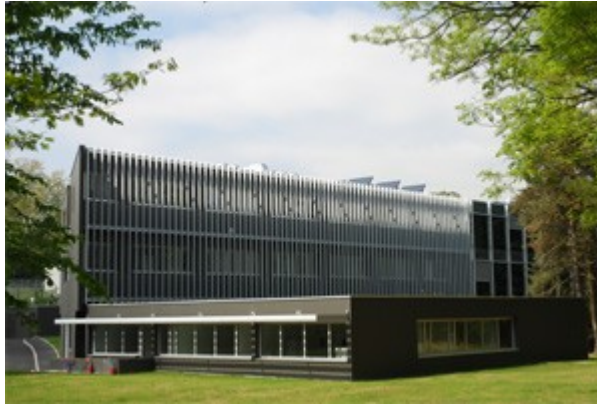
Bâtiment du LNR sur le site de Nantes de l'Ifremer
